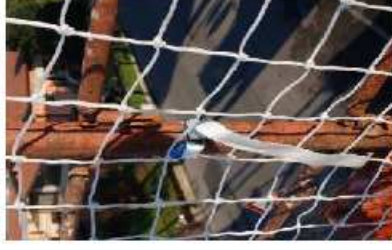
POSIZIONE "B" (fissaggio parte superiore montante principale)
